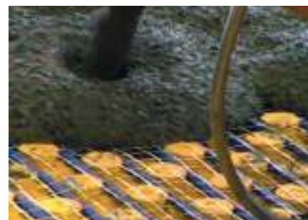
Massetto di calcestruzzo su pavimento radiante
